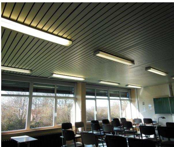
Beispiel Decken: Klassenraum vorher
